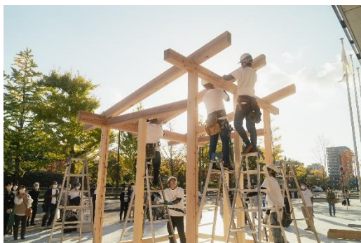
伝統技「墨付け・手刻み」の棟上げ | 実演 大彦
